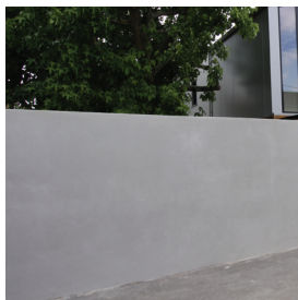
Parpaings enduits - mur bahut hauteur max. 1m
