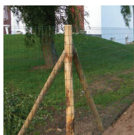
Grillage «à moutons» sur poteaux châtaigniers hauteur max 1,60m
