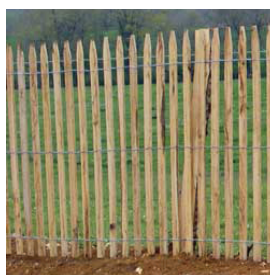
Ganivelles bois sans soutènement maçonné hauteur max 1,60m
